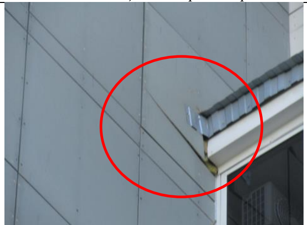
Фото 6 - Скол с выпадением части плиты из облицовки дворового фасада
