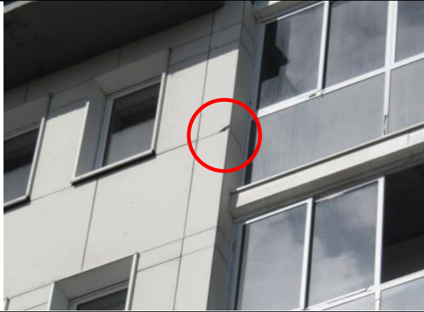
Фото 23 - Скол с выпадением части плиты из облицовки главного фасада
