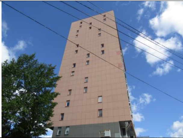
Фото 29 - Левый торцевой фасад. Общий вид.
