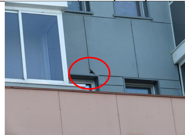
Фото 6 - Скол с выпадением части плиты из облицовки дворового фасада
