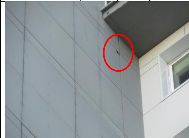
Фото 5 - Скол с выпадением части плиты из облицовки дворового фасада
