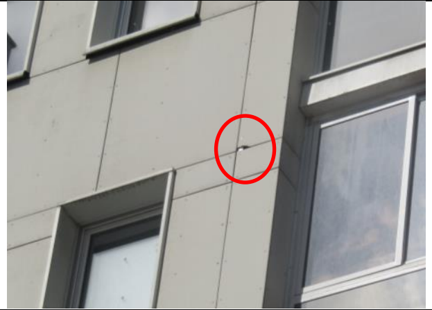
Фото 24 - Скол с выпадением части плиты из облицовки главного фасада
