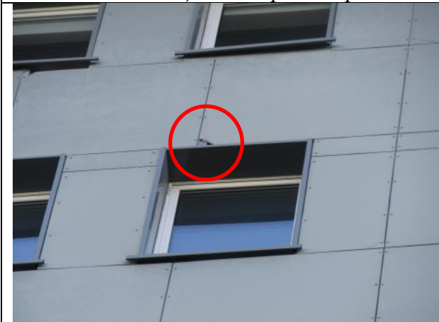
Фото 5 - Скол с выпадением части плиты из облицовки дворового фасада
