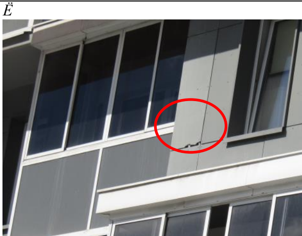
Фото 25 - Сколы с выпадением частей плиты из облицовки главного фасада
