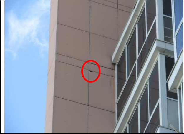
Фото 12 - Скол с выпадением части плиты из облицовки дворового фасада
