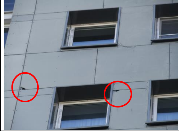
Фото 10 - Сколы с выпадением частей плит из облицовки дворового фасада
