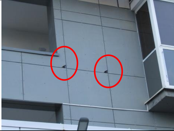
Фото 11 - Сколы с выпадением частей плит из облицовки дворового фасада
