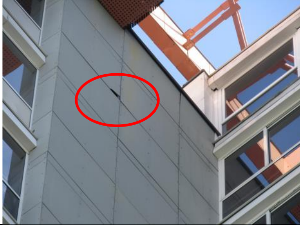
Фото 9 - Скол с выпадением части плиты из облицовки дворового фасада
