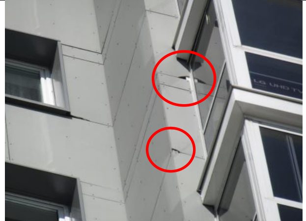
Фото 28 - Сколы с выпадением частей плит из облицовки главного фасада
