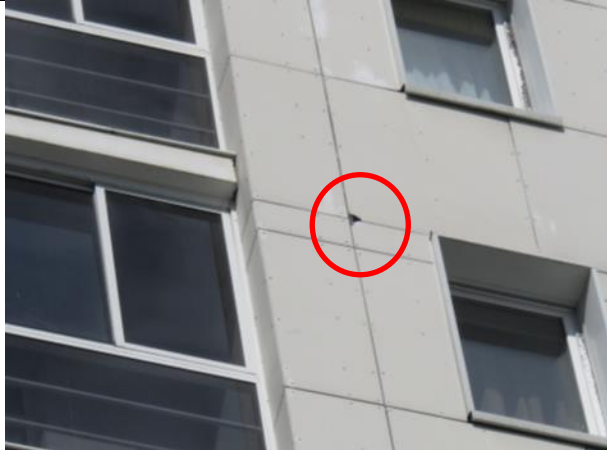
Фото 27 - Скол с выпадением части плиты из облицовки главного фасада
