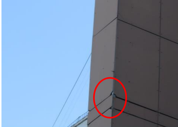
Фото 13 - Сколы с выпадением частей плит из облицовки дворового фасада
