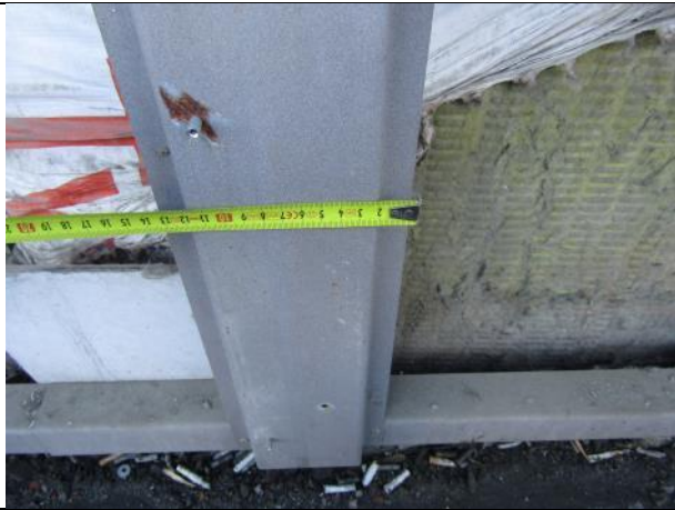
Фото 41 - Металлическая вертикальная направляющая каркаса системы вентилируемого фасада с шириной центральной части 100 мм.
