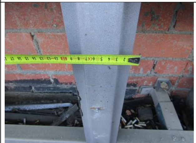
Фото 40 - Металлическая вертикальная направляющая каркаса системы вентилируемого фасада с шириной центральной части 50 мм.
